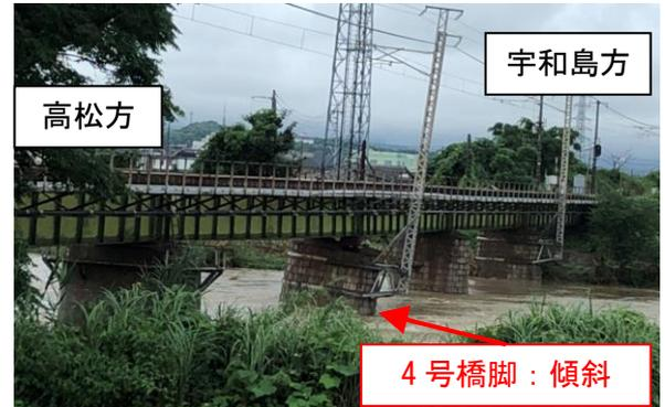
図-1 予讃線財田川橋梁の被災状況
