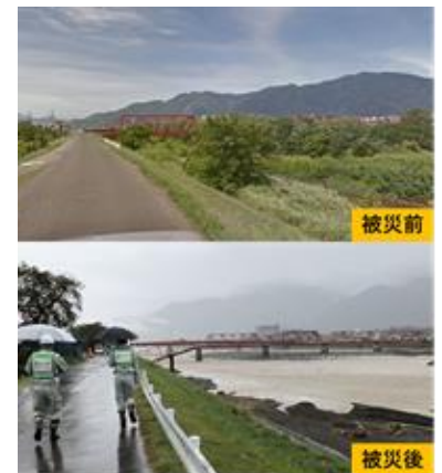
図-2 被災部の被災前後写真
