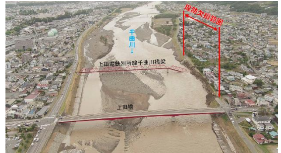
図-1 被災部上空写真 2)
