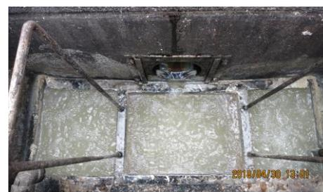
図 2 高知自動車道南国 SA 上り線のグリストラップ排水の流入部
