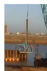
鋼矢板の取り込み
