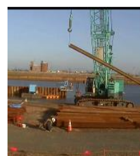
鋼矢板のつり込み作業
