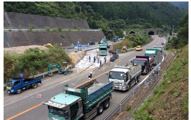
図 5 渡り線施工状況
