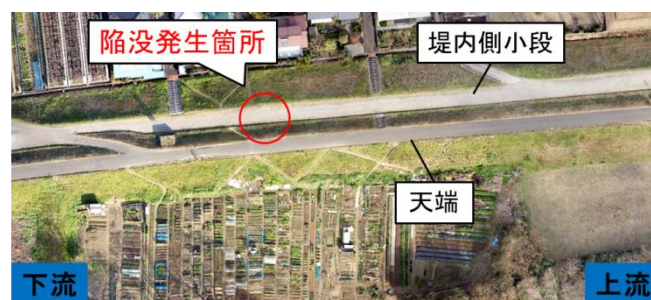
図 2 重信川右岸 2.4k 地点の陥没箇所
