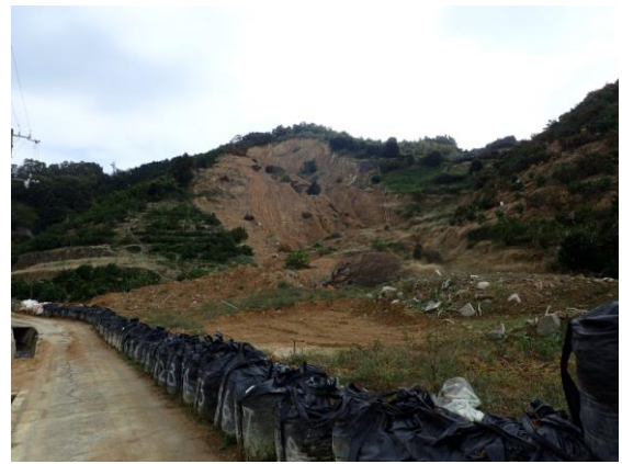
写真1 白浦地区の斜面崩壊現場（11月9日撮影、この崩壊により、4名が犠牲になった。）
