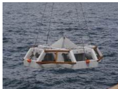
図2 流動制御機能を有する人工魚礁
