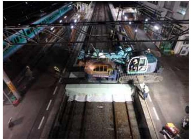
図-2 工事用仮設通路と施工機械搬入状況
