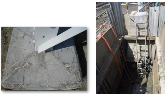
(a) 基礎体天端部
