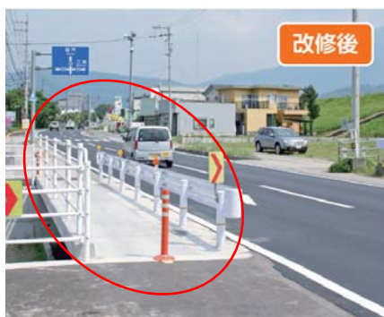
写真-1 改修前後の状況 1)
