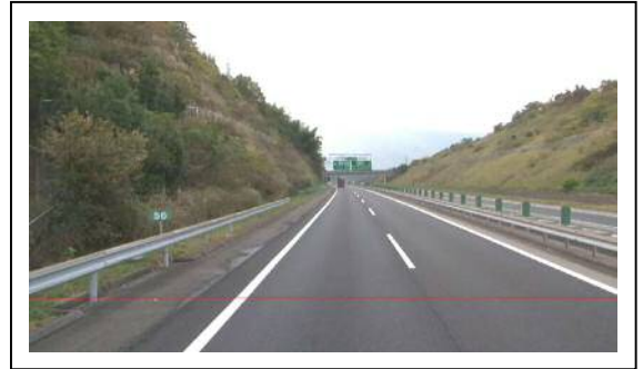
写真-1 川之江切土のり面
