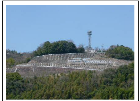
写真-2 花園切土のり面
