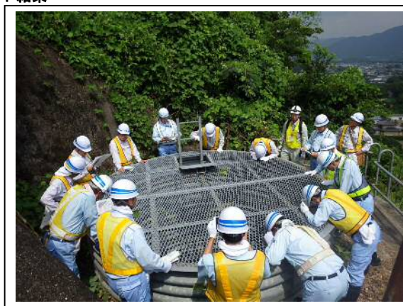
写真-4 地すべり施設の現地調査
