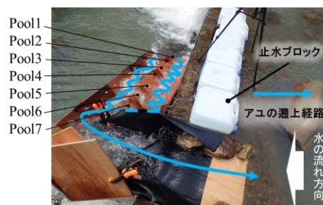
図-2 提案魚道の設置状況
