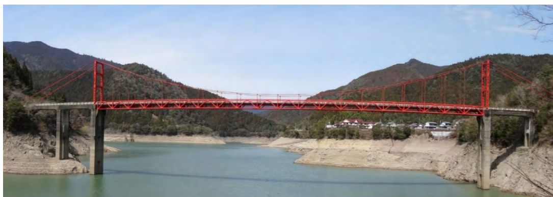
写-1 対象橋梁写真
