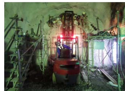
写真－2 I 期線覆工の撤去状況
