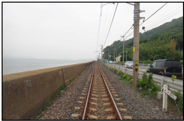
写真 1 施工箇所（終点方から望む）
