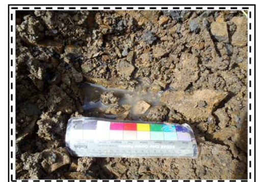
写真-3 Aのり面 地下水位
