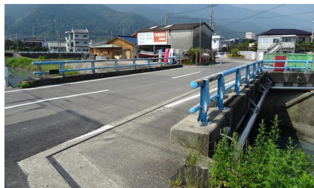
図-1 静進橋外観
