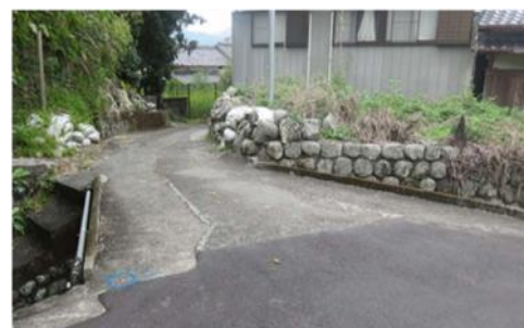
図-1 K 橋現況写真
