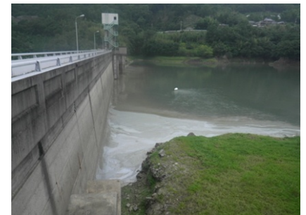
写真-1 アオコが発生した殿川ダム
