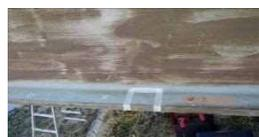
(a) 塗膜残存部の塗膜除去後の状況
