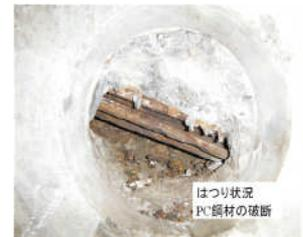
写真-2 PC 鋼材の腐食状況
