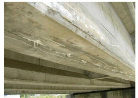
写真-1 PC桁の損傷写真
