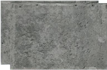
写真－２ セメント瓦の表面性状
