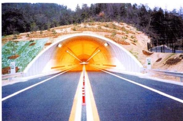
写真-2 竹割式先端拡幅構造<sup>1)</sup>
