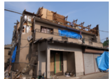
写真-1 竜巻による家屋への被害 (2012年5月 茨城県つくば市)
