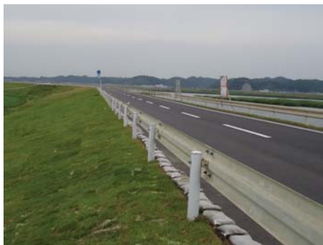
写真 1 地震後の河川堤防の状況
