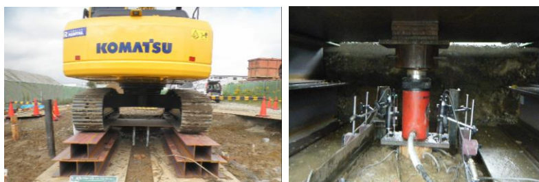
写真-1 載荷試験の様子
