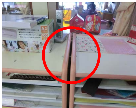
写真1 ボルトで連結することにより 転倒しにくくしている乳児保育室の棚
