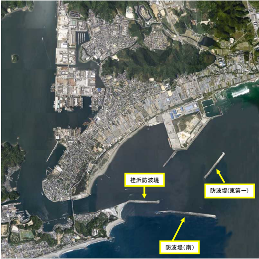
写真1 高知港第一線防波堤平面写真
