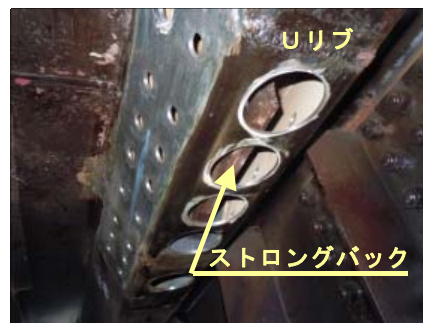
写真-2 ストロングバック状況
