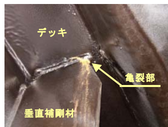
図-3 デッキプレートと垂直補剛材の溶接部
