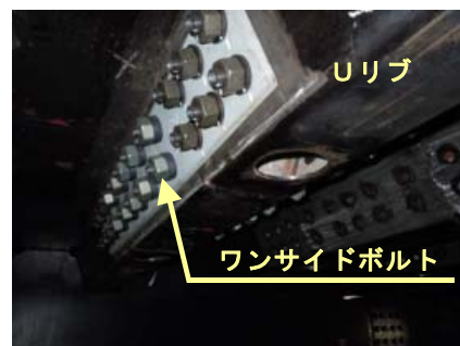
写真-3 あて板設置状況
