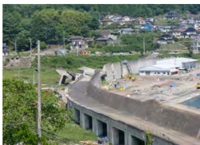
写真 1 岩手県釜石市唐丹町防潮堤
