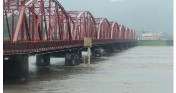
図-1 四万十川橋周辺の出水状況(2011 年 7 月)
