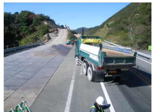
写真-1 現場入退場ゲート
