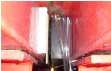
写真-2 遊間調整樹脂注入状況
