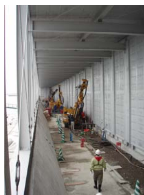
写真-3 施工状況
