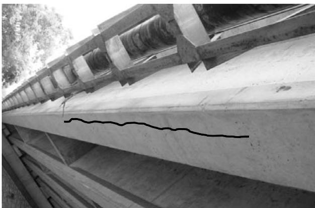
図 1 ASR の劣化を受けた PC 構造物のひび割れ
