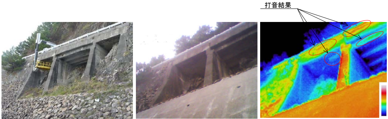
写真-3 点検状況及び赤外線サーモグラフィ
