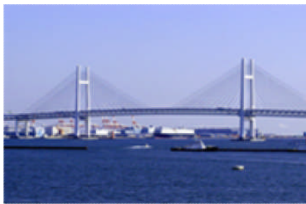
写真1 横浜ベイブリッジ
