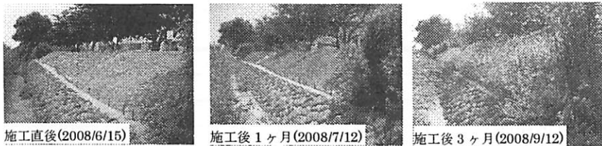
写真－1 植生状況 (施工箇所の上流より撮影)
