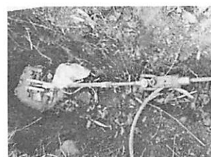
写真-2 緩衝金具設置状況
