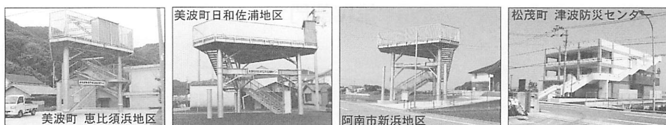
写真1 徳島県下の津波避難施設写真
