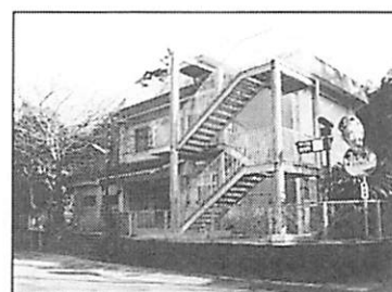
写真2 既存の公民館への外部階段設置
