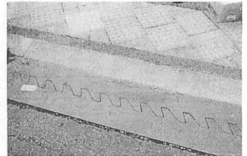
写真 1 伸縮装置の遊間
