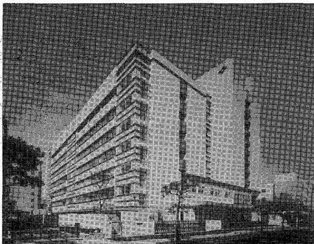
図1. 建物外観(左:新館、右:本館)
