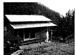
図2：住民施工による休憩所
