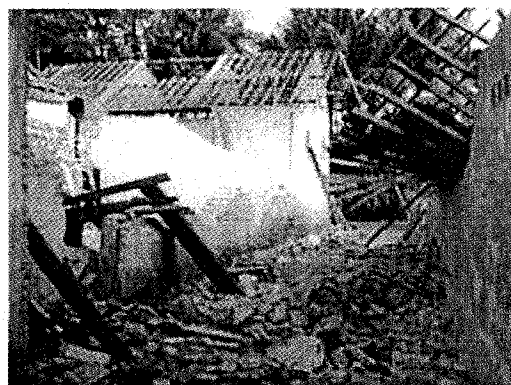
写真-1 全壊した住宅
