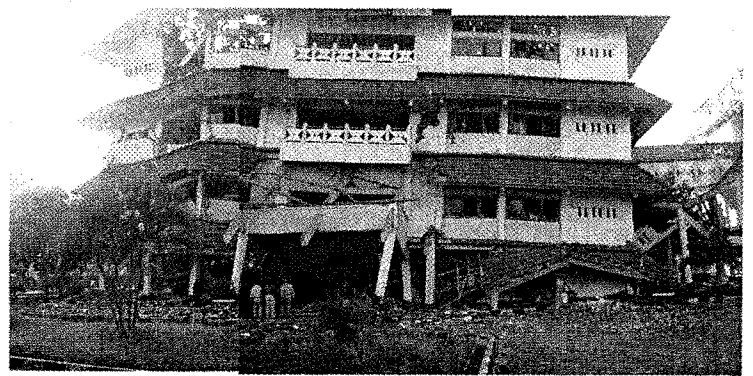
図-4 経済大学校舎 (RC 造) の崩壊状況
