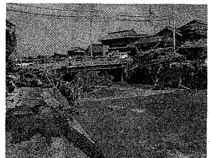
写真-1 妙之谷川の洪水氾濫 （妙之谷川橋直上流）
