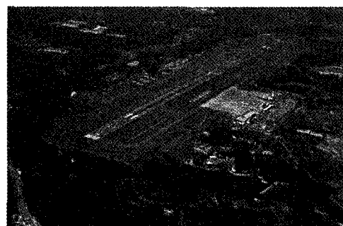
写真-1 高松空港航空写真
