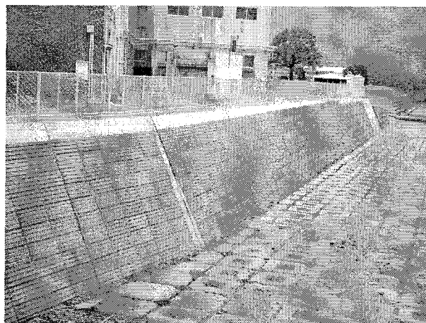
写真-4 擁壁完成図
