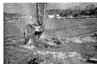
写-1 土壌改良材攪拌状況
