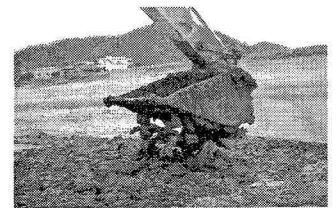
写-2 土壌改良材の攪拌
